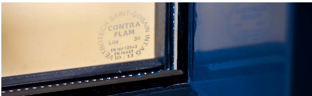
Figuur 5.1: N.B. de hoek waarin de stempel in het brandwerend glas is gemarkeerd, dient aan de onderzijde te worden gemonteerd
