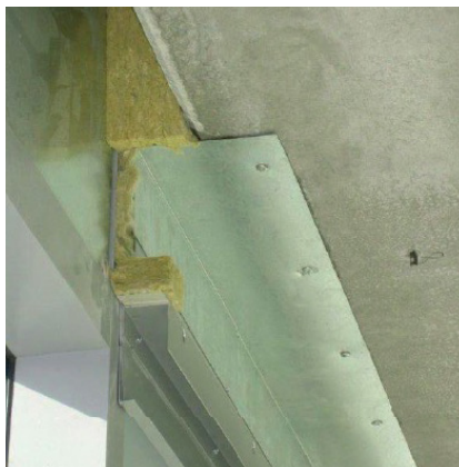
Afb. G.6: Aansluiting schort
