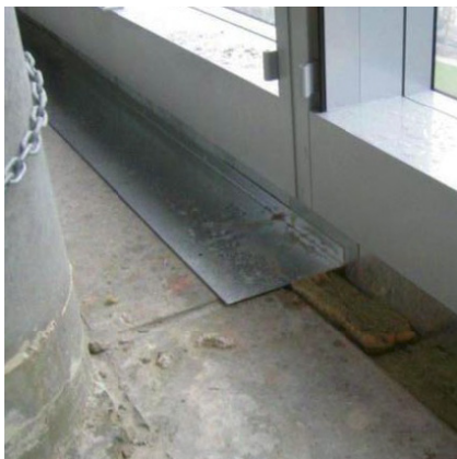
Afb. G.5: Aansluiting borstwering
