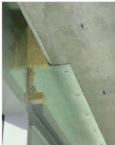
Figuur 40: Aansluiting schort
