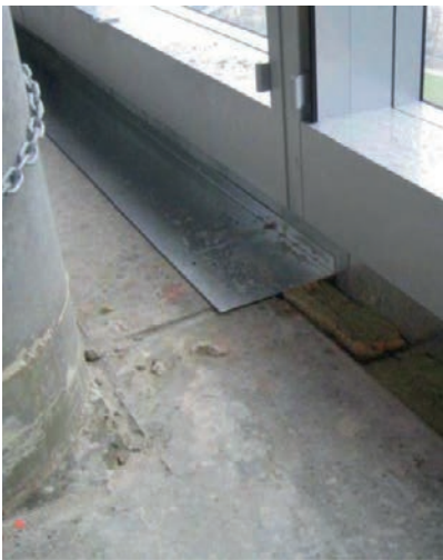
Figuur 39: Aansluiting borstwering
