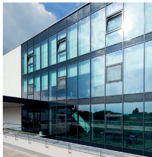
Figuur 38: Voorbeeld van een vliesgevel
